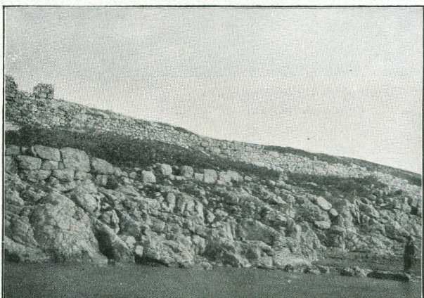
Kerinthos (Eubea) — Le mura poligonali dell'Acropoli sopra il fiume Buduros.
