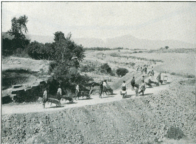
Gortina (Creta) — Lavori per la deviazione del fiume Leteo dall'edificio della « Grande Iscrizione ».
